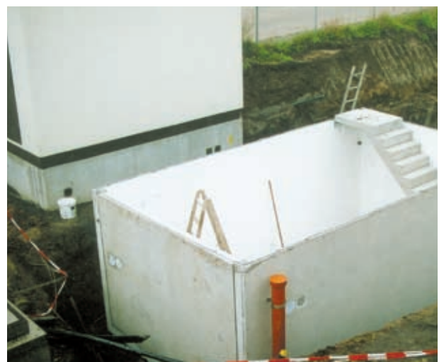
Die Fertiggarage wird auf das versenkte Keller-Element gesetzt
