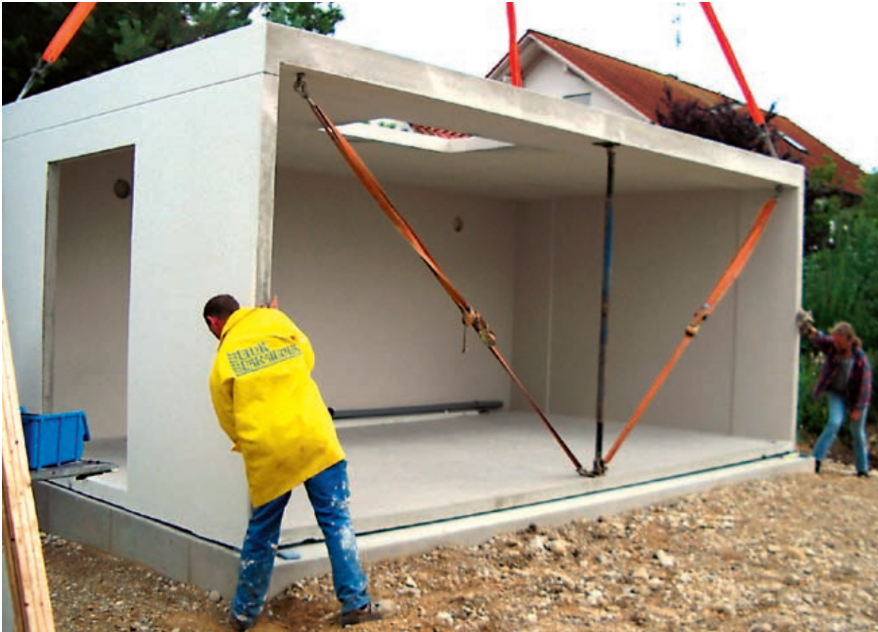
Maßarbeit: Die Garage wird exakt auf das Fundament abgesenkt
