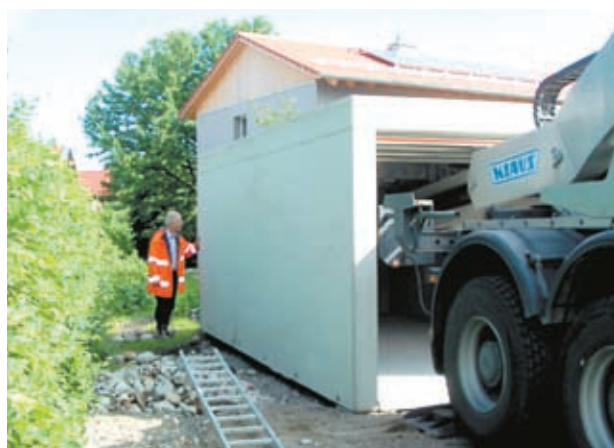
Schwerstarbeit: Leistungsfähige Montage-Fahrzeuge heben Ihre Garage an den richtigen Platz
