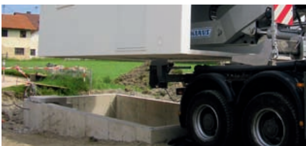
Die Fertiggarage wird auf das versenkte Keller-Element gesetzt
