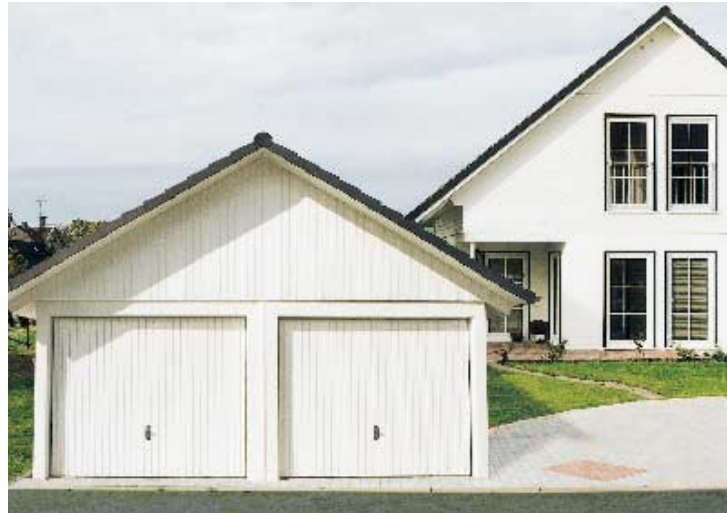
Doppelgarage „ Flöha “ - harmonisch abgestimmt
