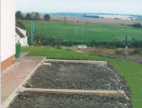
zur Lieferung der Garage vorbereitete Fundamente
