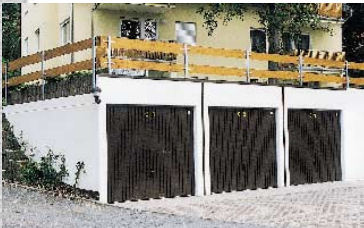
Hang-Garagen „Görlitz“ mit Terrasse und Brüstung über Torbereich
