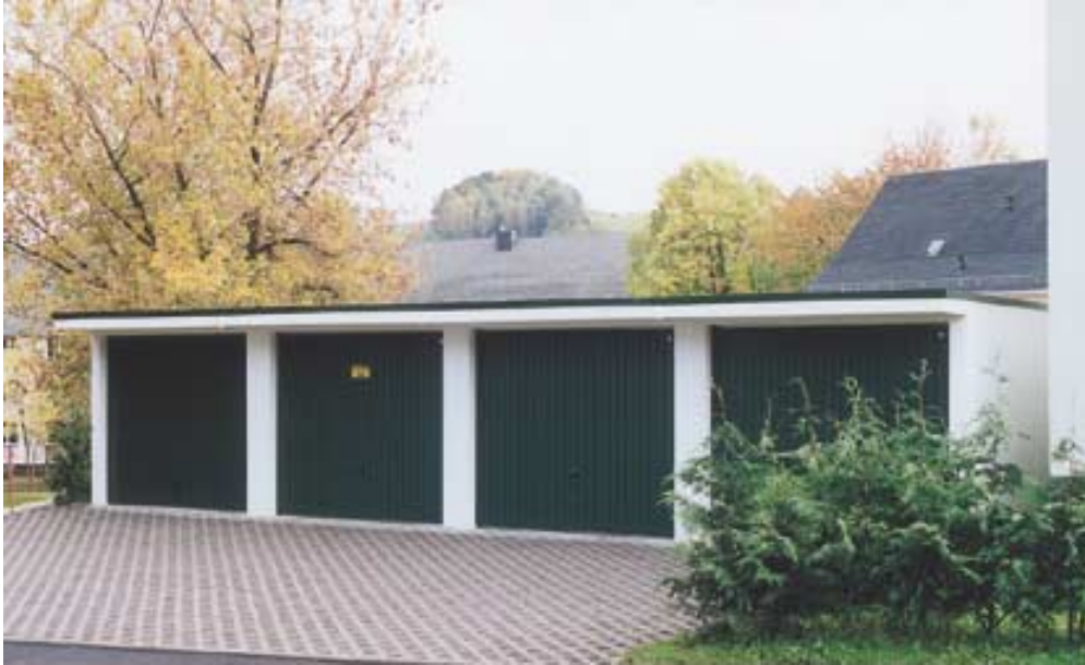
Reihenanlage „Zschopau“ mit Vordach
