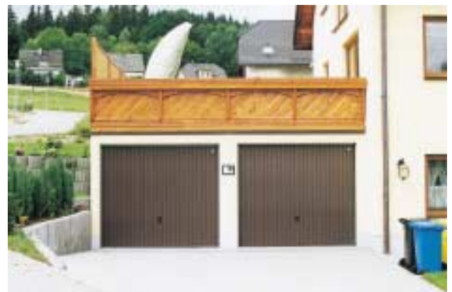
Hang-Garagen „Geyer“ mit Terrassennutzung
