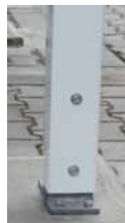
Höhenverstellung über Stützenfüße (+15/-5 cm) durch Rohr-in-Rohr-System.
