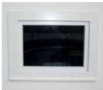
Neues Dreh-/Kipfenster mit Isolierglas
