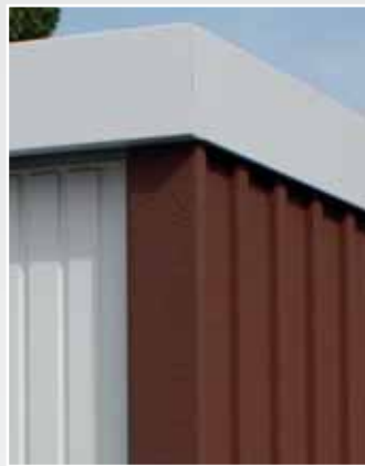
Ausführung Strukturwand mit Dekorputz
