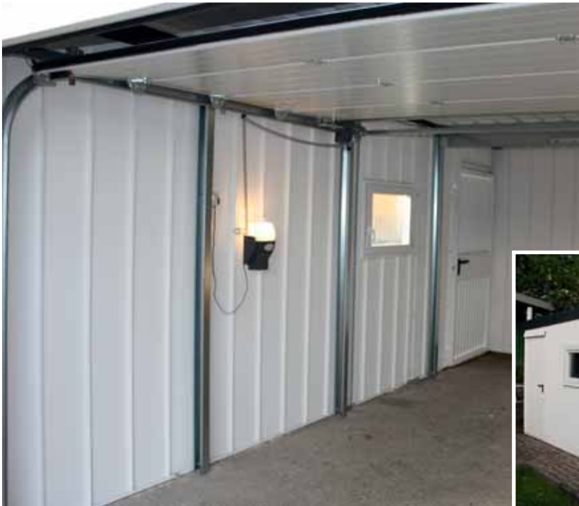
Innenansicht mit Torantriebssystem, Fenster und Nebentür
