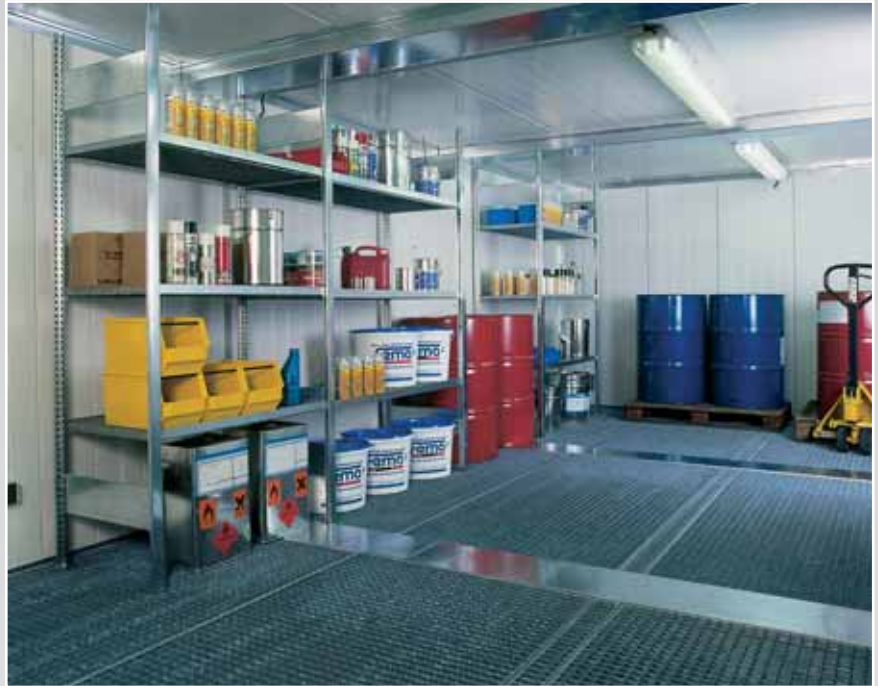
Innenansicht mit SC-Regal und Elektroinstallation
